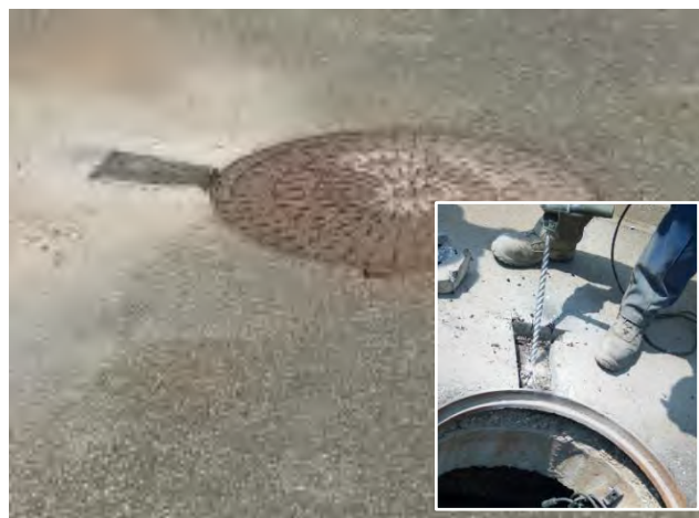
Antenne sous enrobés
