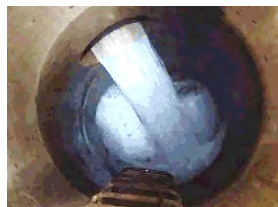
Photo : déversement des eaux de source dans le réseau d'assainissement
